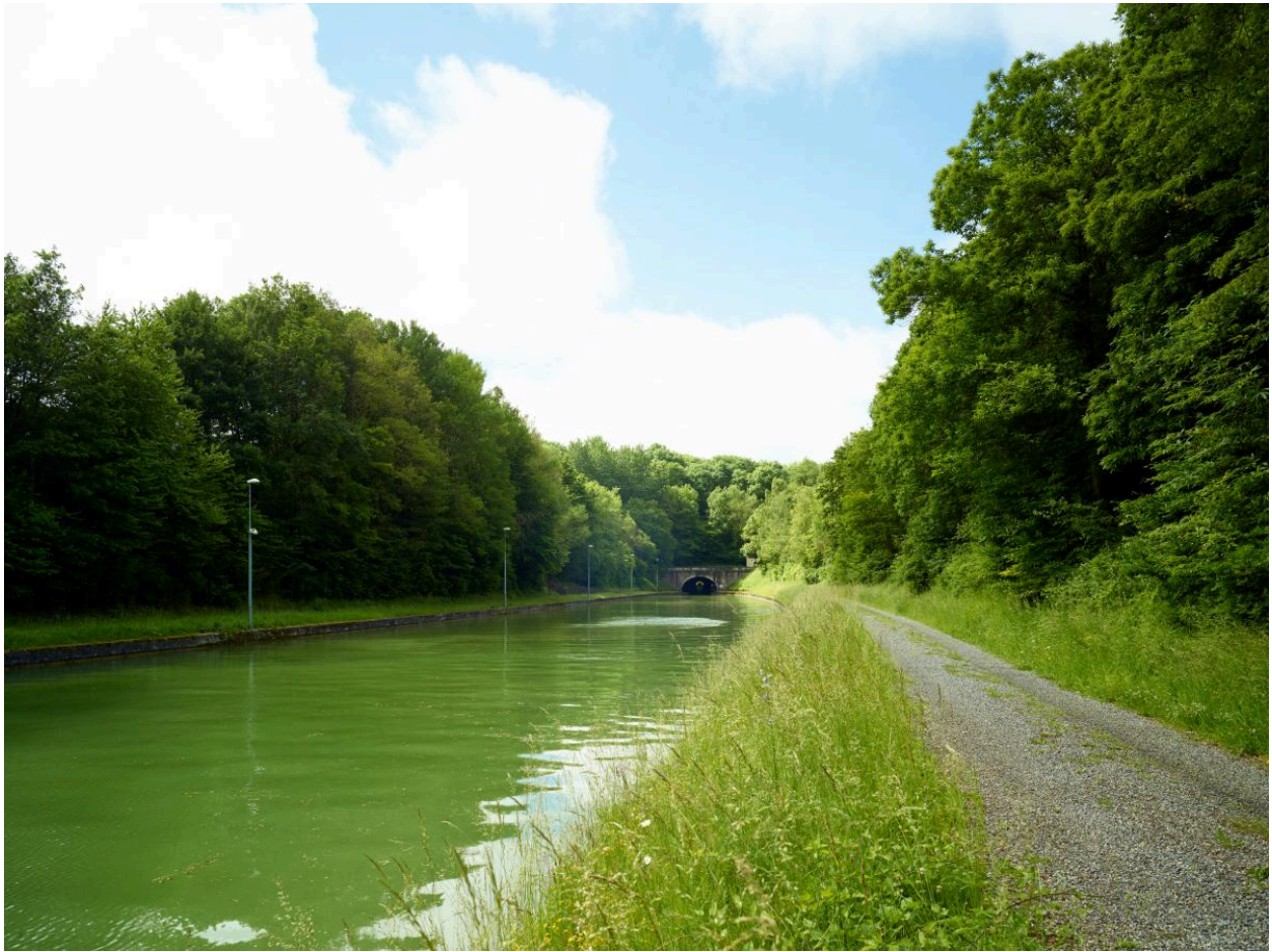
Tête d'entrée nord et voie de circulation.
