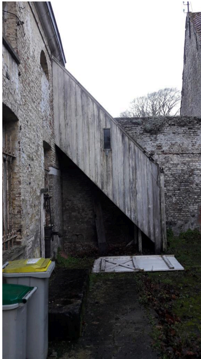
Ferme des berceaux : escalier extérieur droit encagé en bois menant au premier étage de la laiterie en 2017 (détruit).
