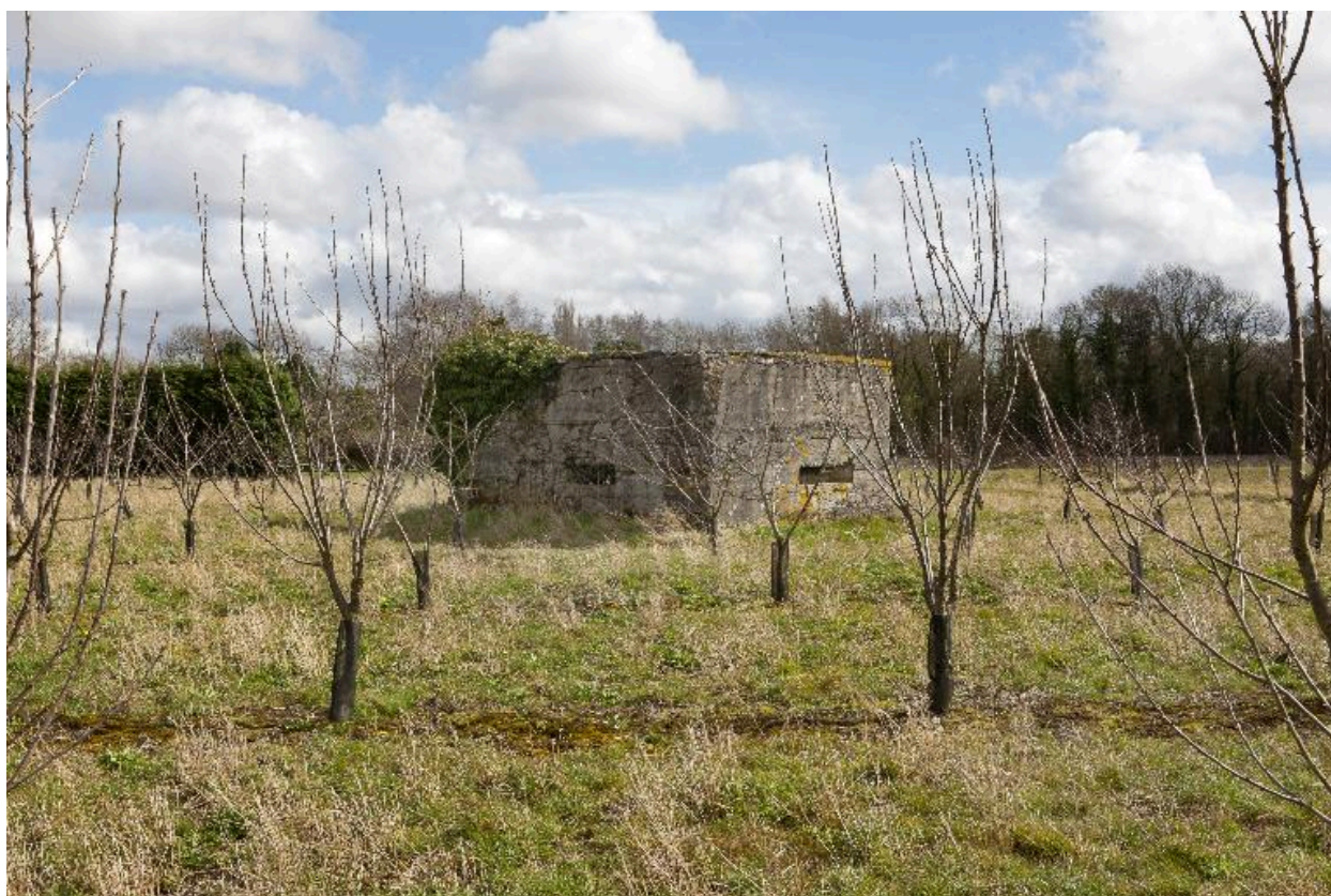
Vue vers le sud-est
