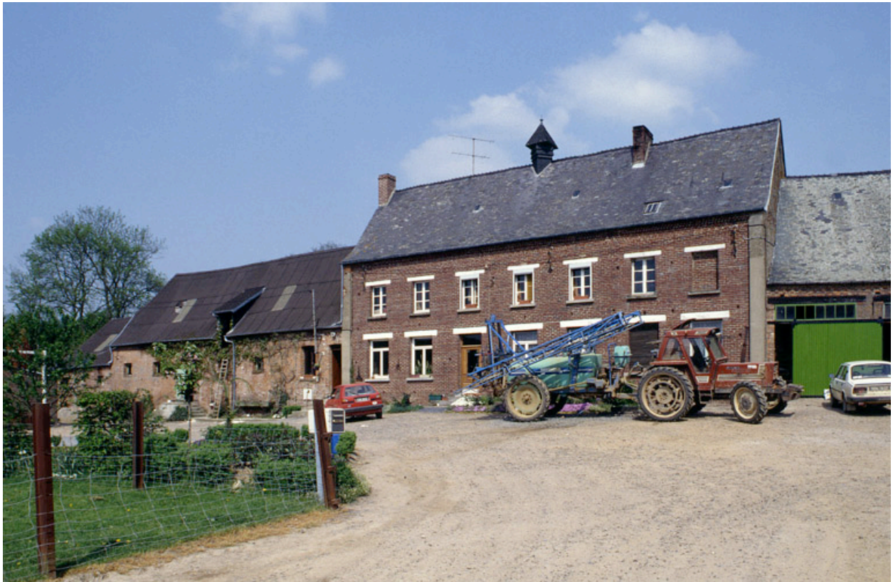
Vue d'ensemble du logis, depuis le sud-ouest.
