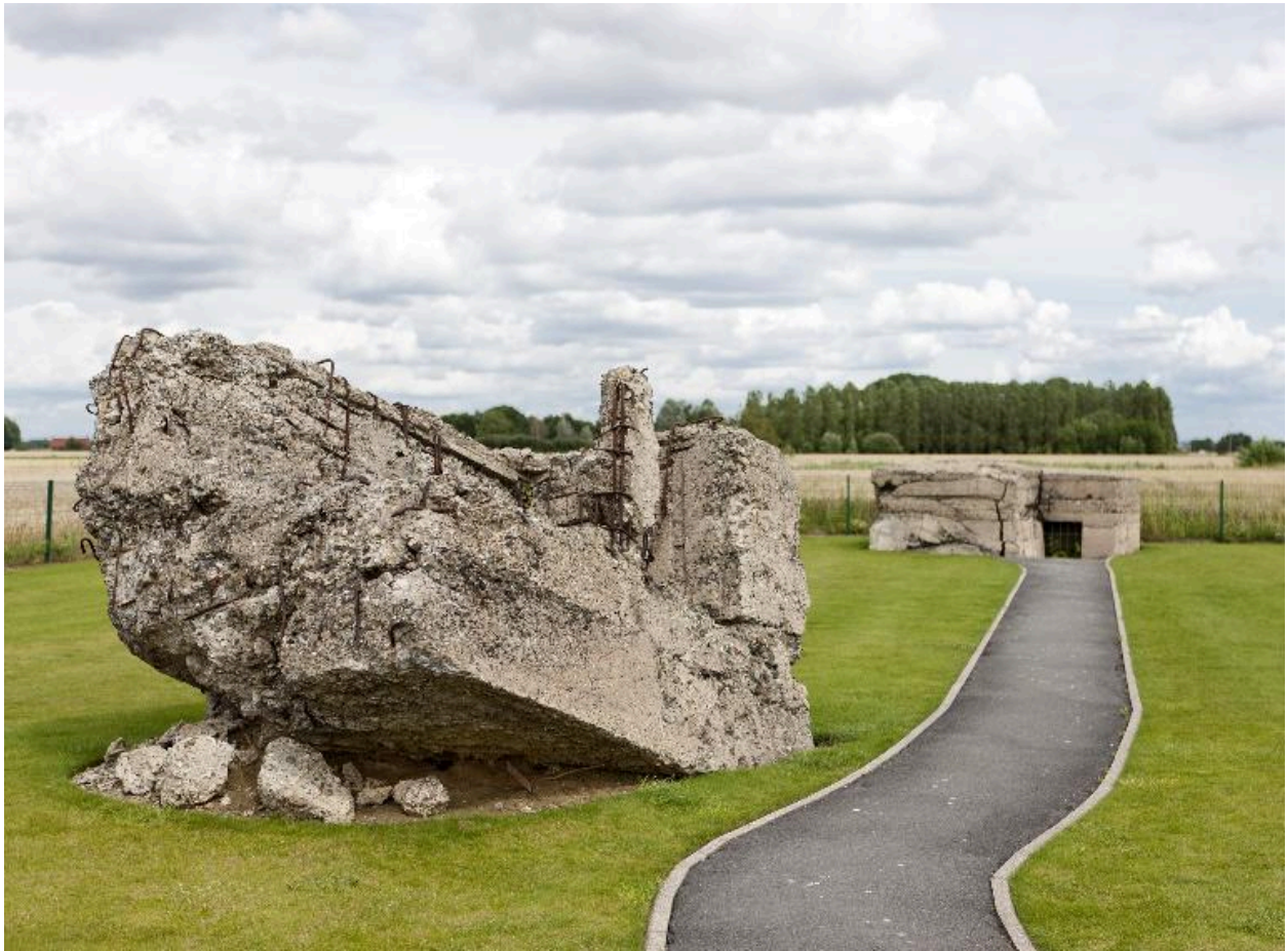
Vestiges de la casemate (e) retournée lors de l'explosion d'une mine, vers le nord-ouest
