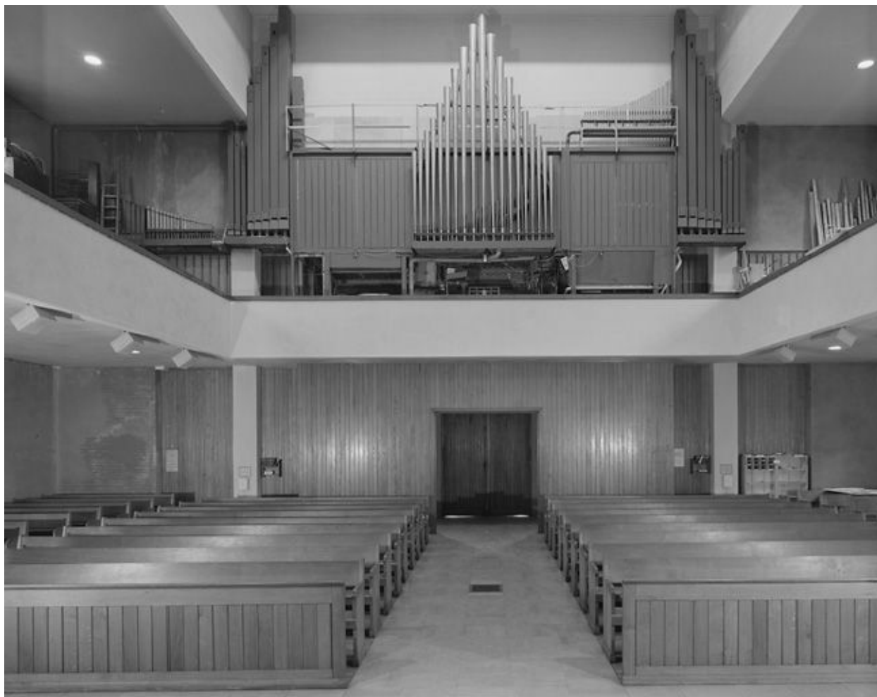
Vue intérieure depuis le chœur.
