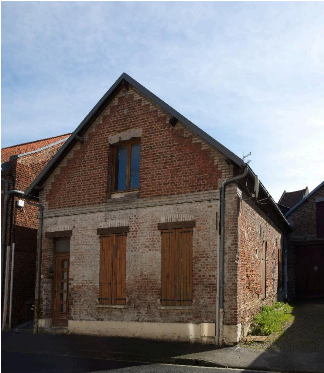
Maison, 23 rue Marchande.
