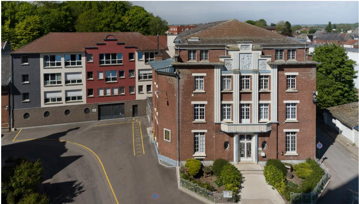
Vue générale de face de l'ensemble des bâtiments du collège depuis la place de l'église.
