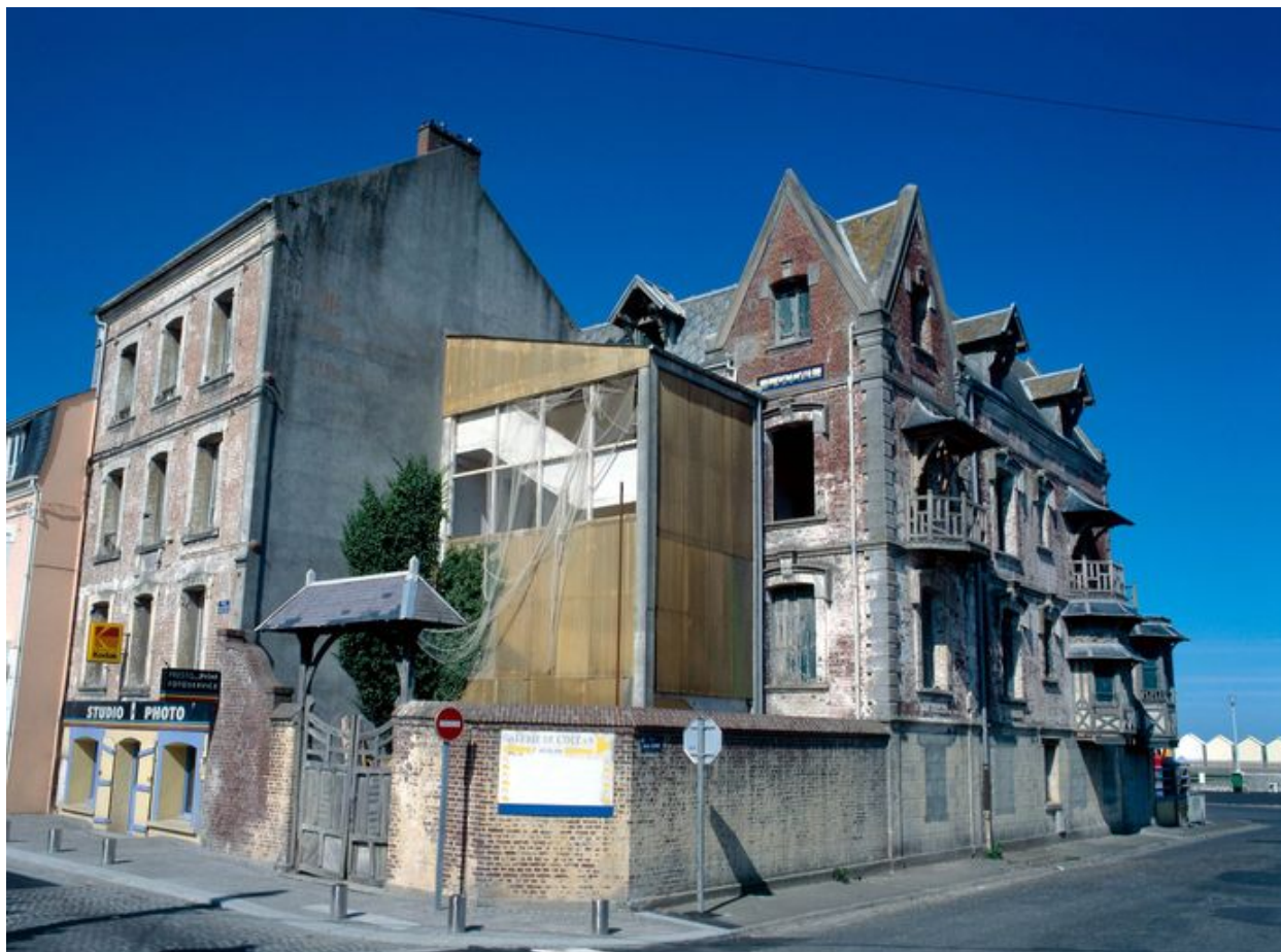
Elévation postérieure, rue du Général-Leclerc.
