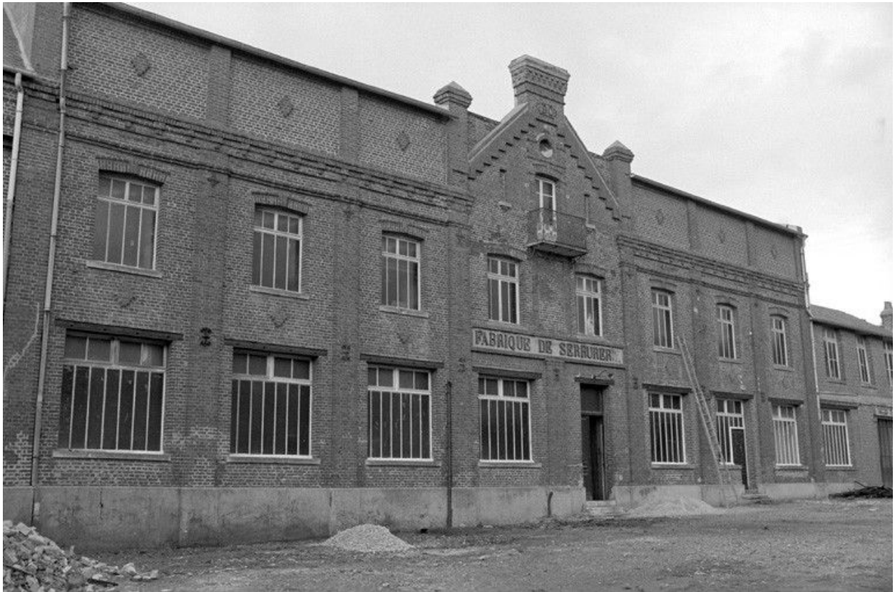
Atelier de fabrication, élévation antérieure, en 1990.
