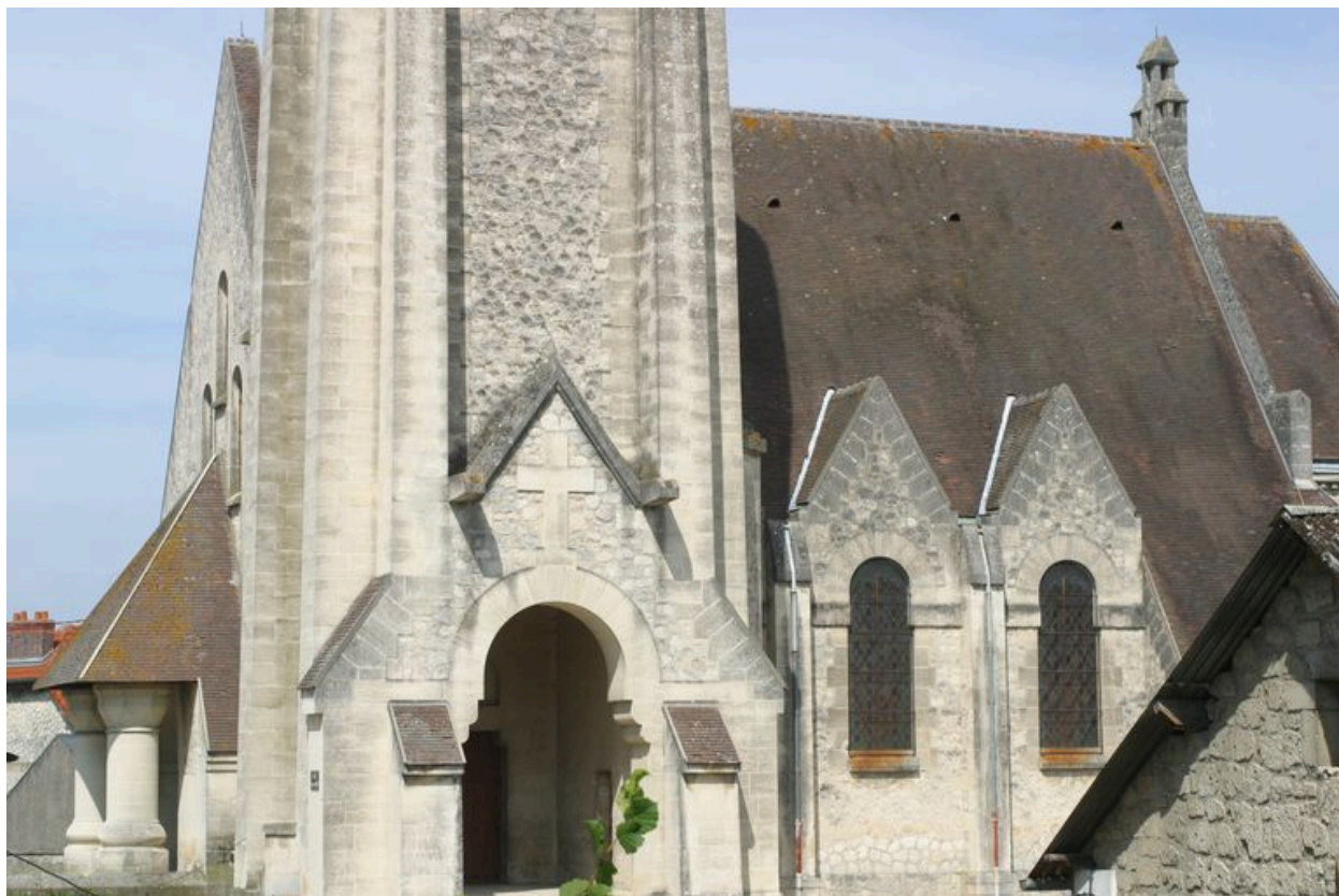
Vue de la face sud.
