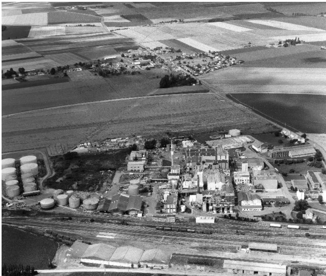
Vue aérienne, flanc sud.
