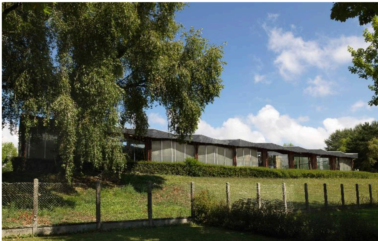
Façade sud, depuis le camping.
