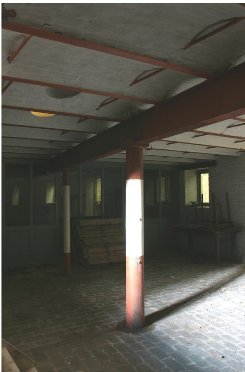
Sous-sol de l'atelier de 1900.
