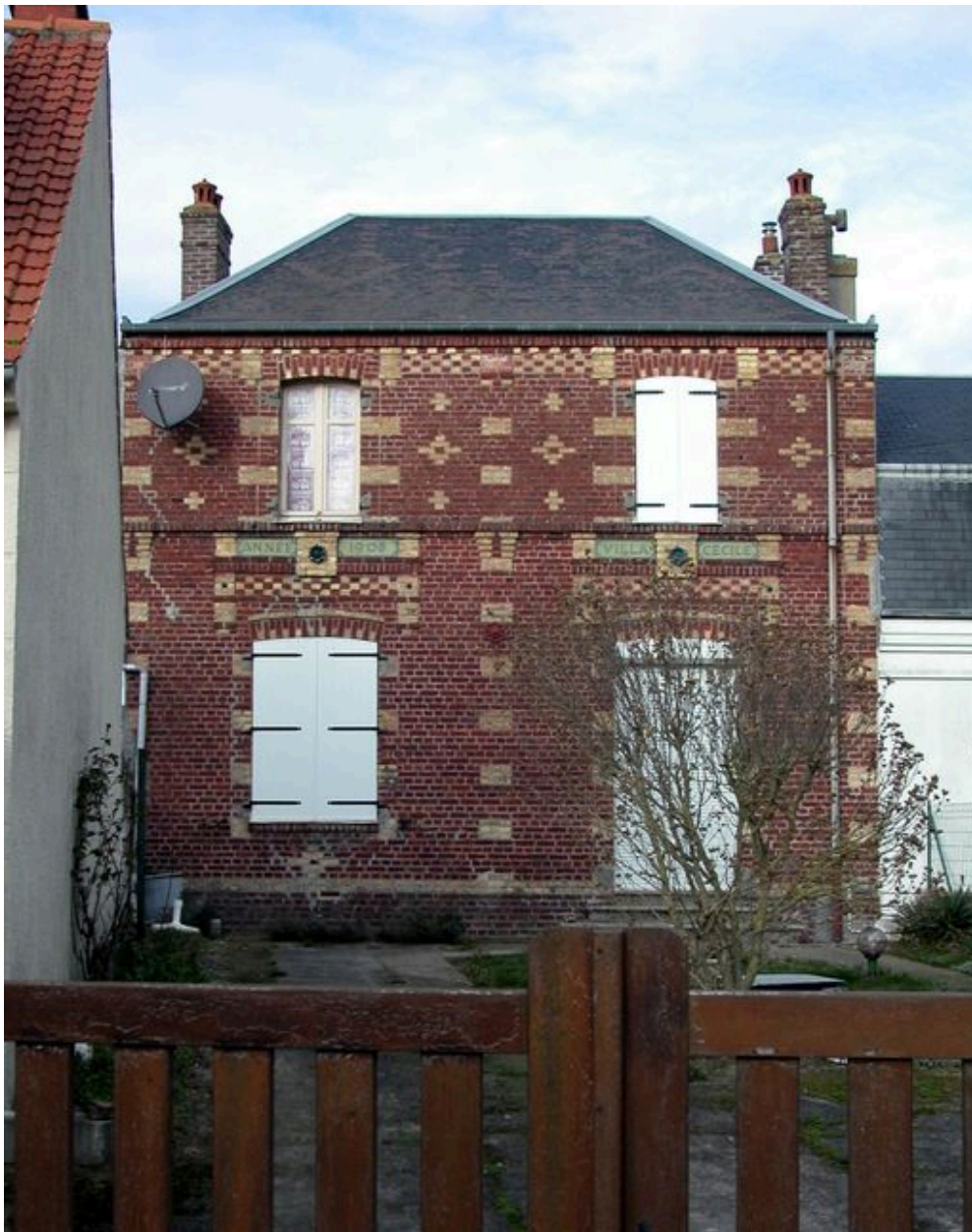
Vue d'ensemble avant travaux.
