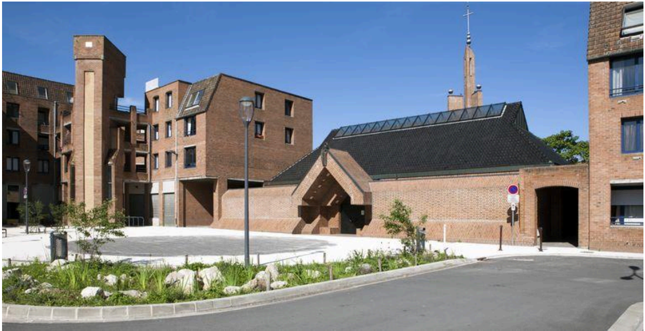
Vue de trois quart de l'élévation antérieure.
