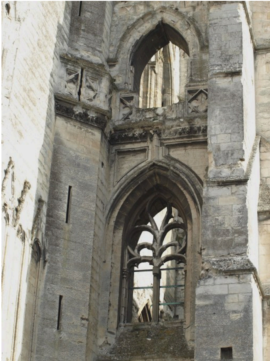
Baies ouest du bas-côté sud
