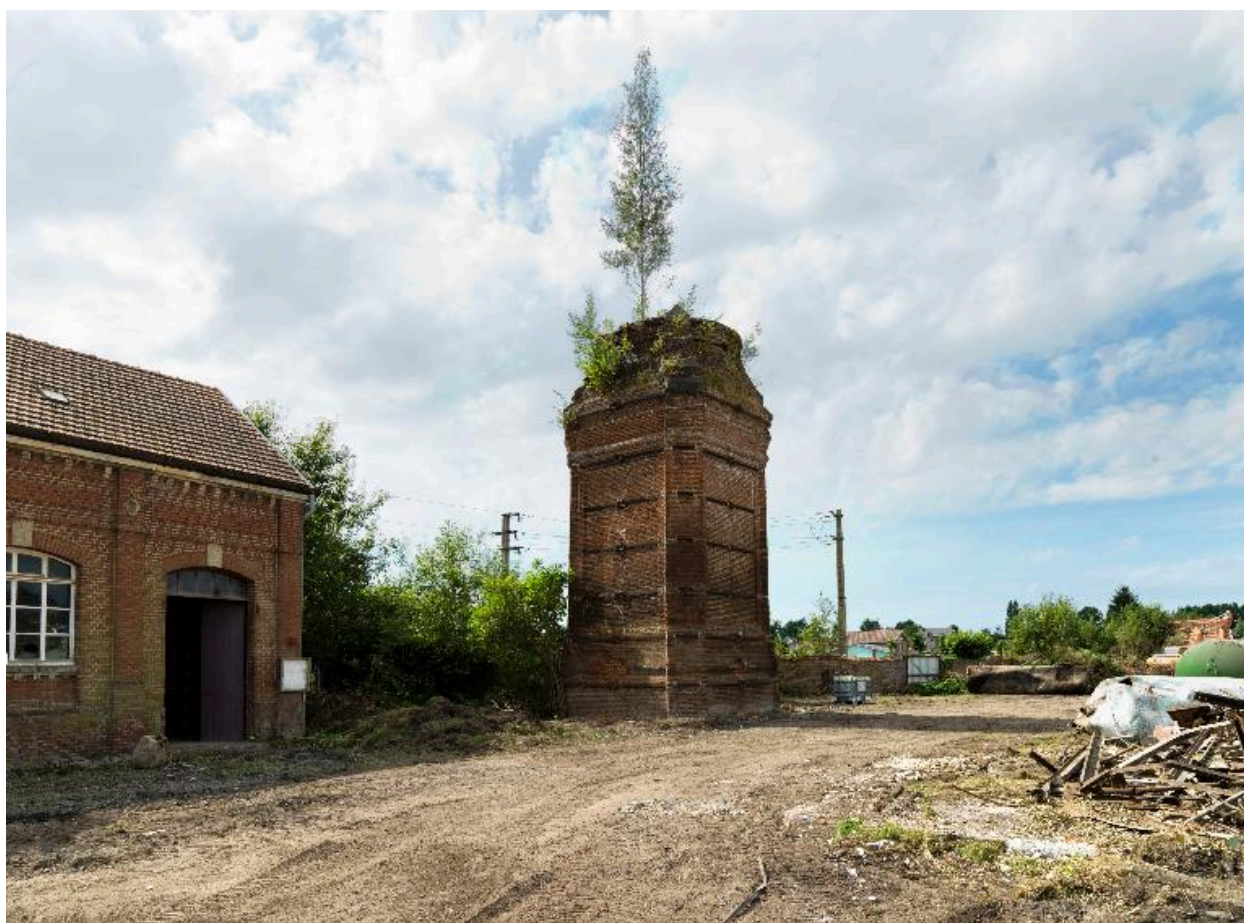
Vestiges de la cheminée de l'usine, juillet 2012.
