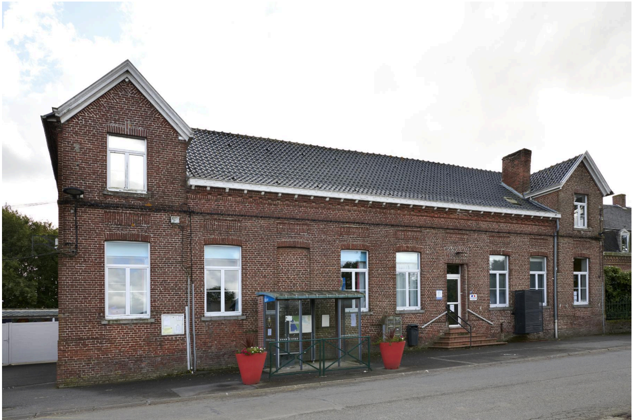
Façade principale sur rue.
