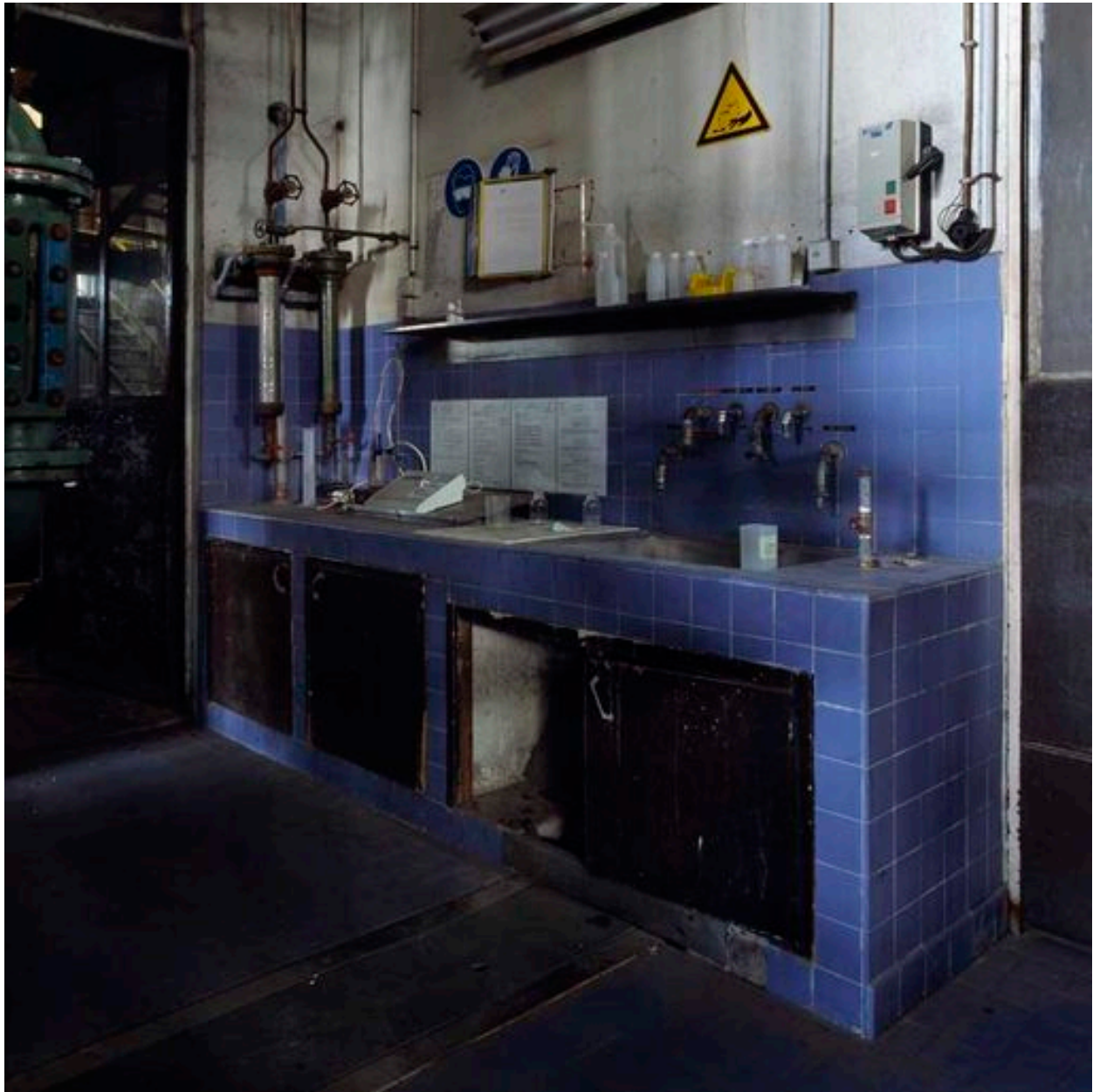
Paillasse au premier étage de la centrale.
