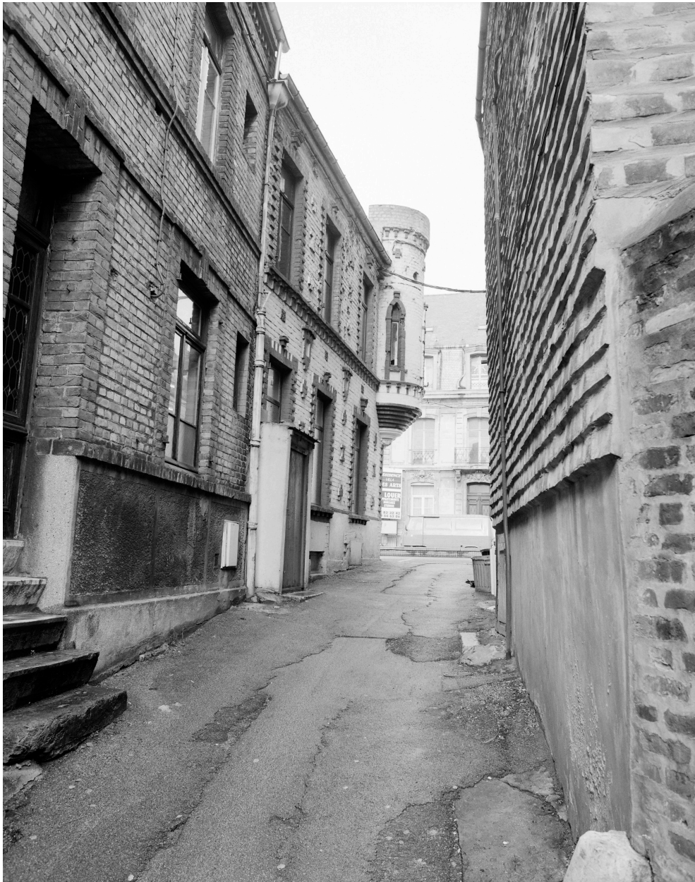
Vue générale sur impasse.
