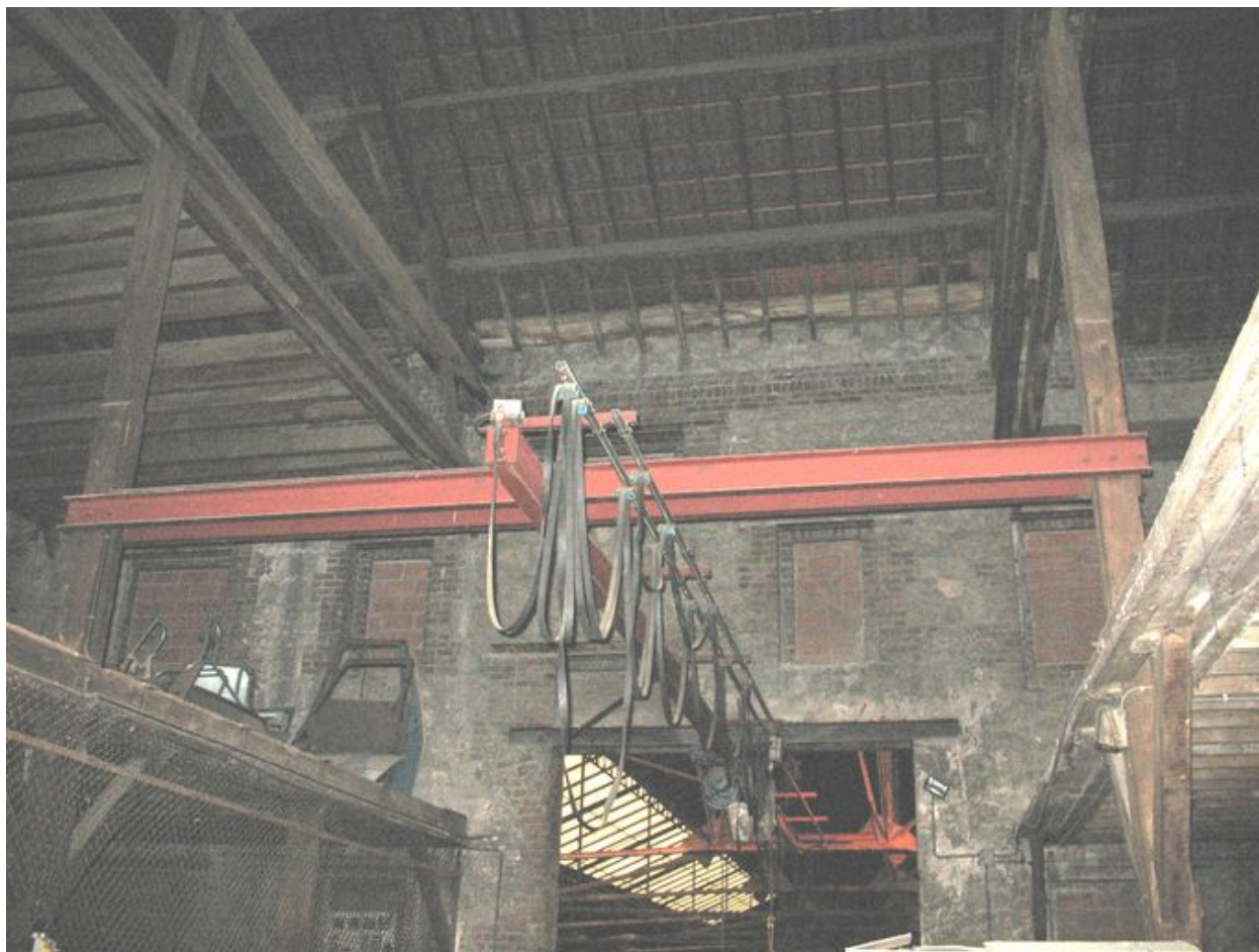
Premier étage de l'ancien relais de chevaux.
