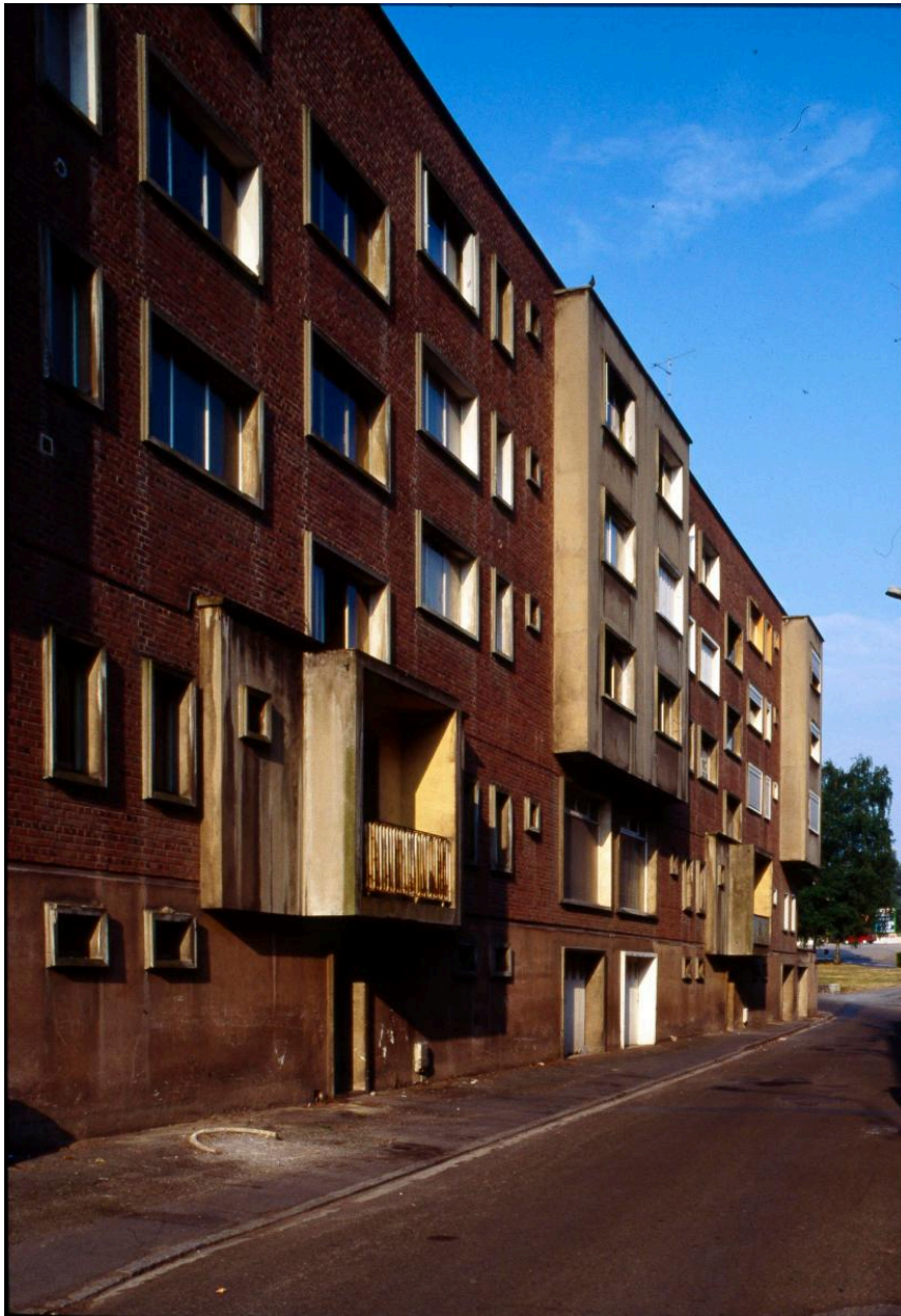
Vue générale de l'élévation postérieure.
