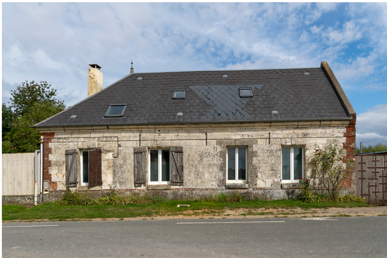
Logis en pierre, n°4 de la Chaussée Brunehaut, vue depuis l'est.
