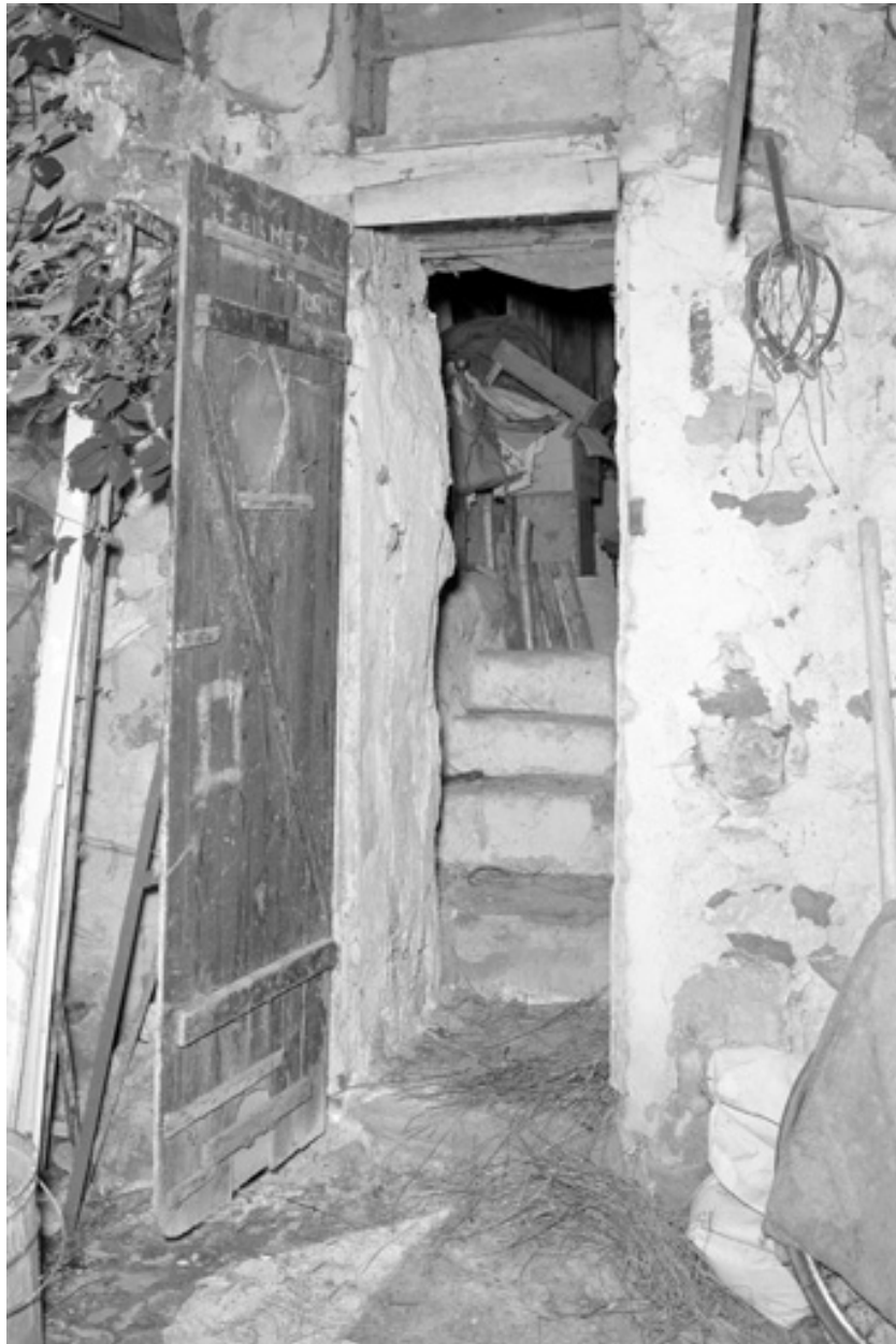
Entrée du bâtiment sur la cour intérieure.
