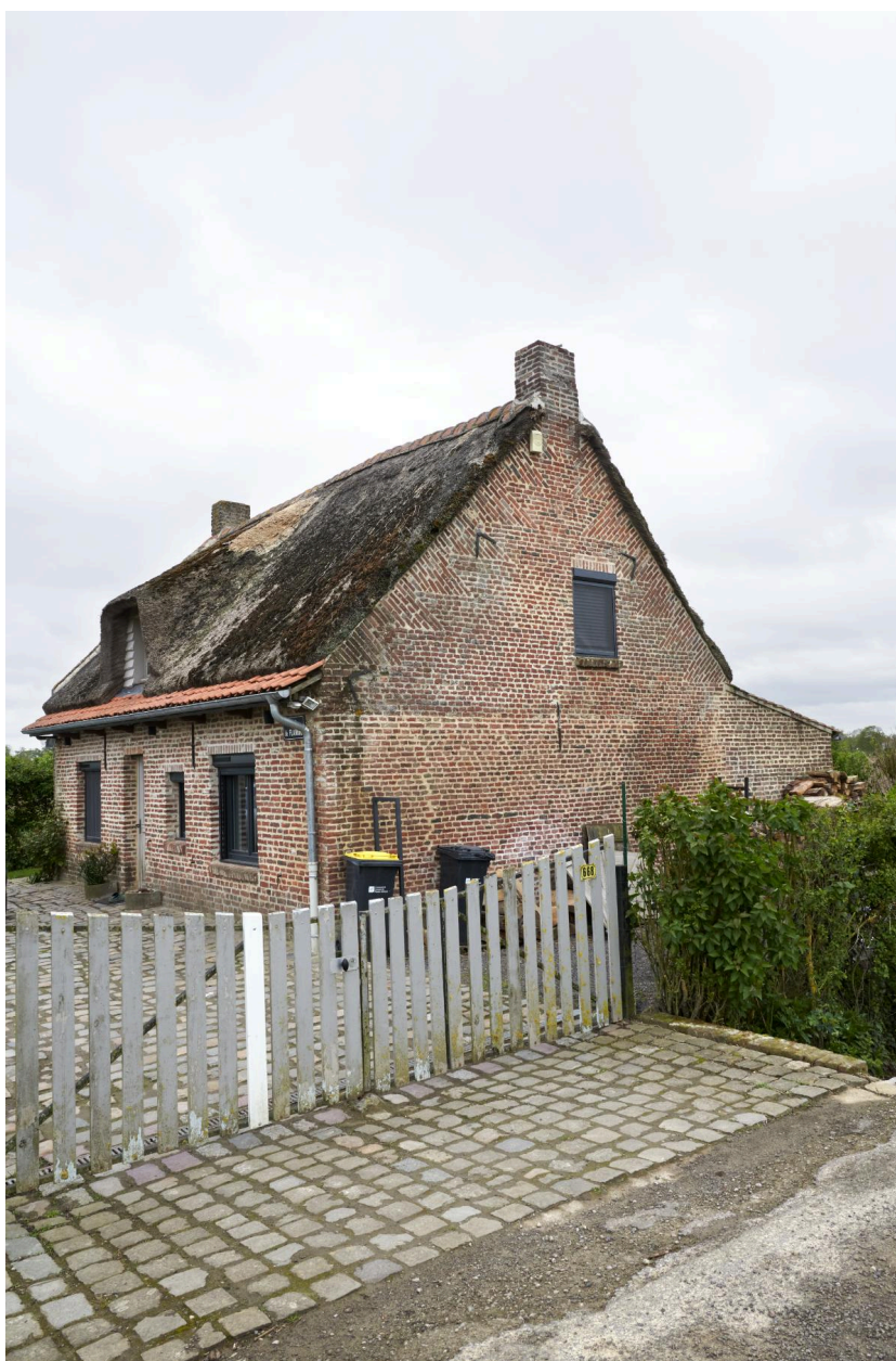
Vue du pignon est et de la façade sud.
