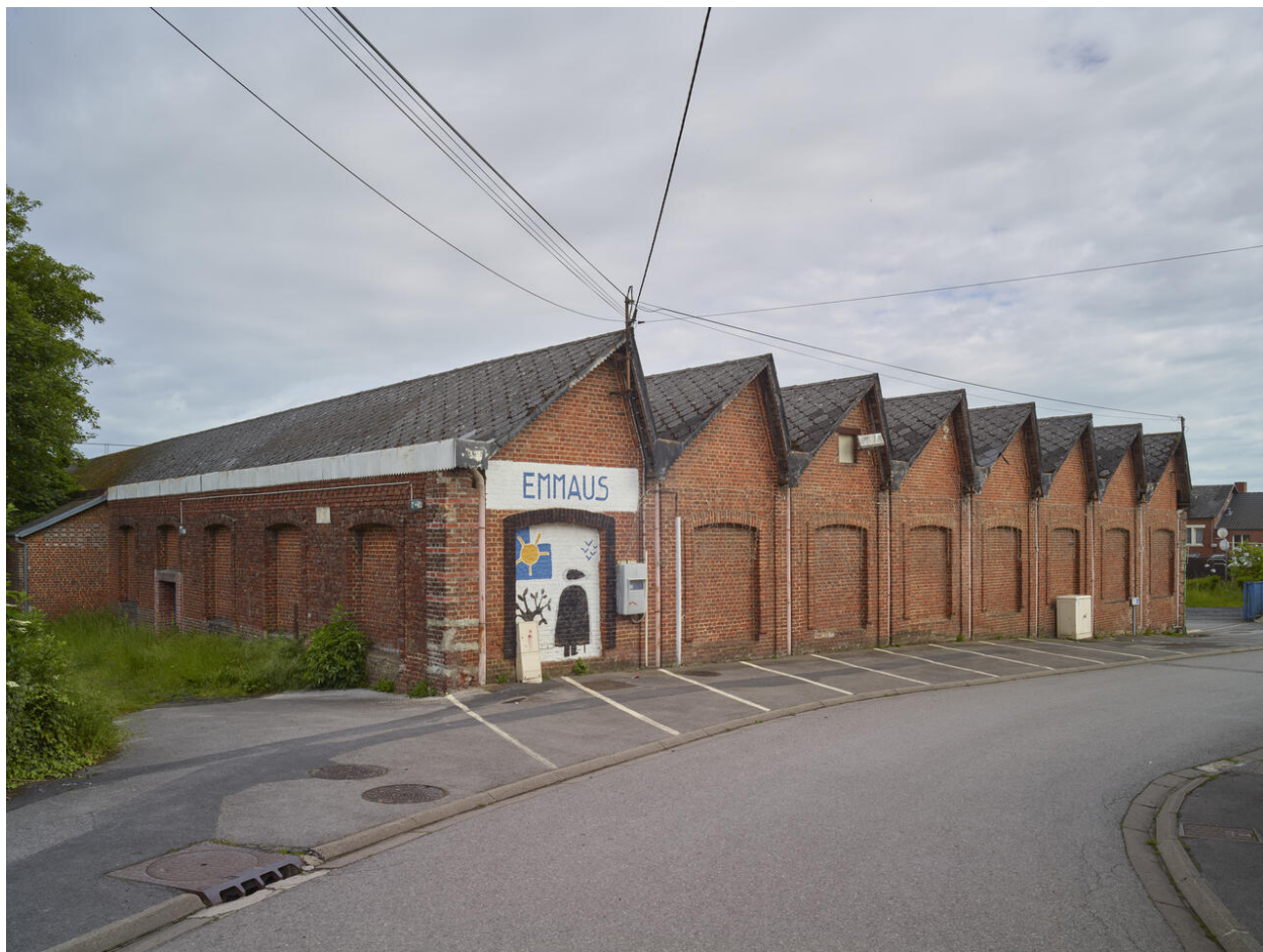
Vue d'ensemble d'une partie des anciens ateliers de la filature, vue depuis le nord-est.
