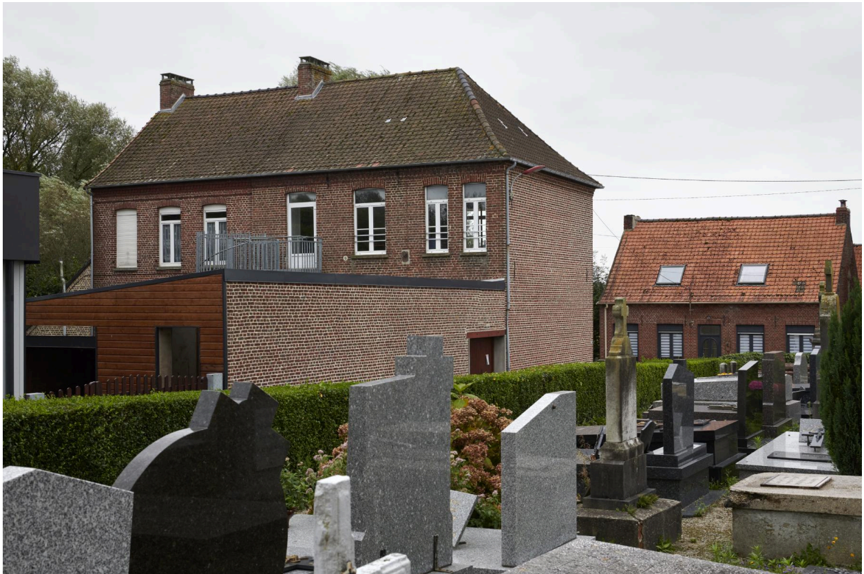
Façade nord (arrière du bâtiment) et pignon ouest.
