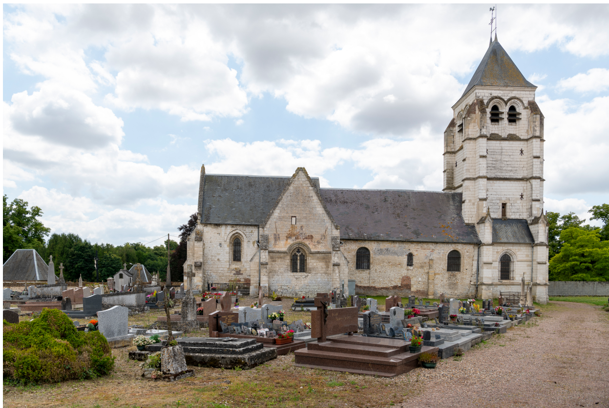
Vue générale depuis l'angle nord du cimetière.
