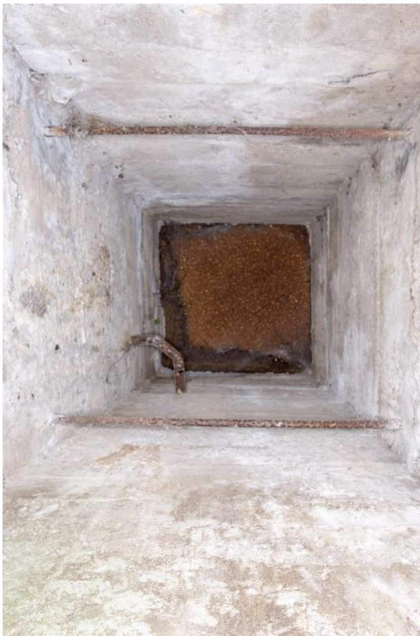
Vue zénithale du poste d'observation
