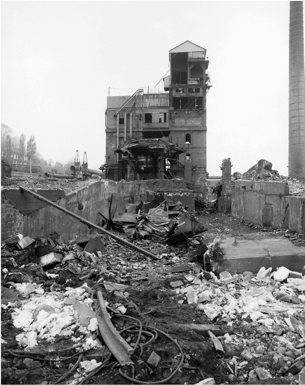
Elévateur, façade sud.
