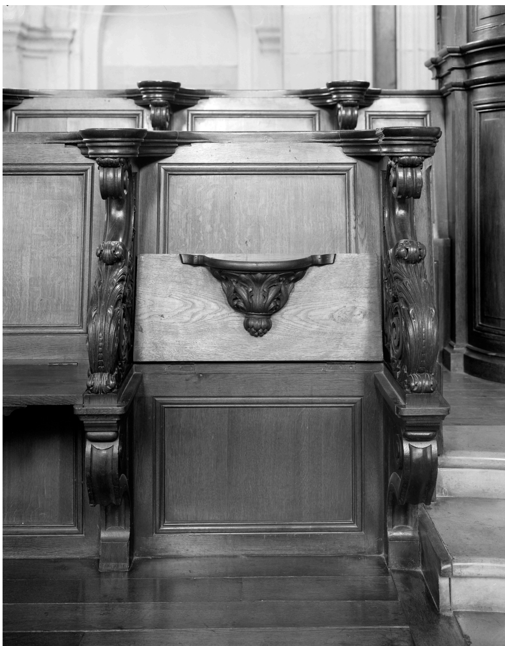
Stalle, vue de face d'un élément.
