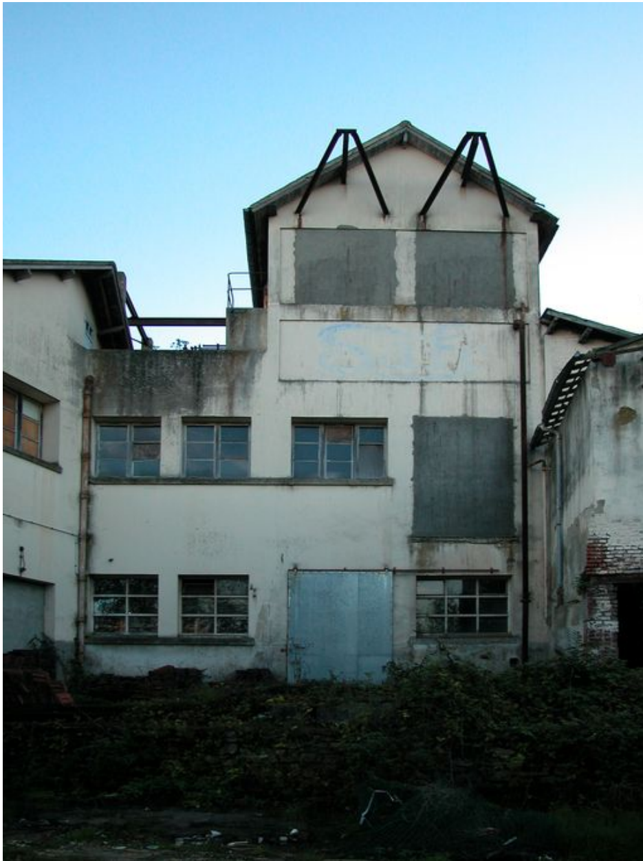
Atelier de fabrication, façade nord.
