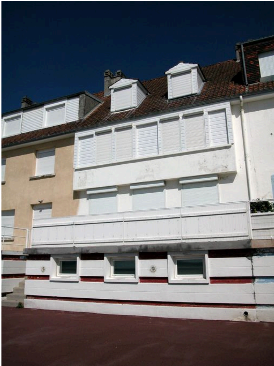
236 boulevard maritime sud (Véga), façade sur mer.
