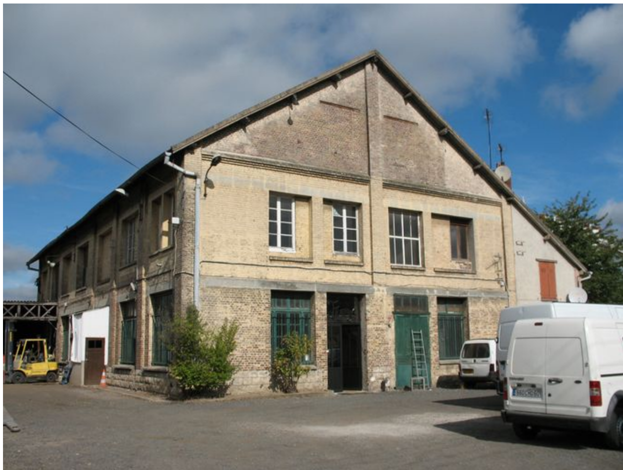
Vue générale de l'ancien atelier des fûts d'emballage et des bureaux.
