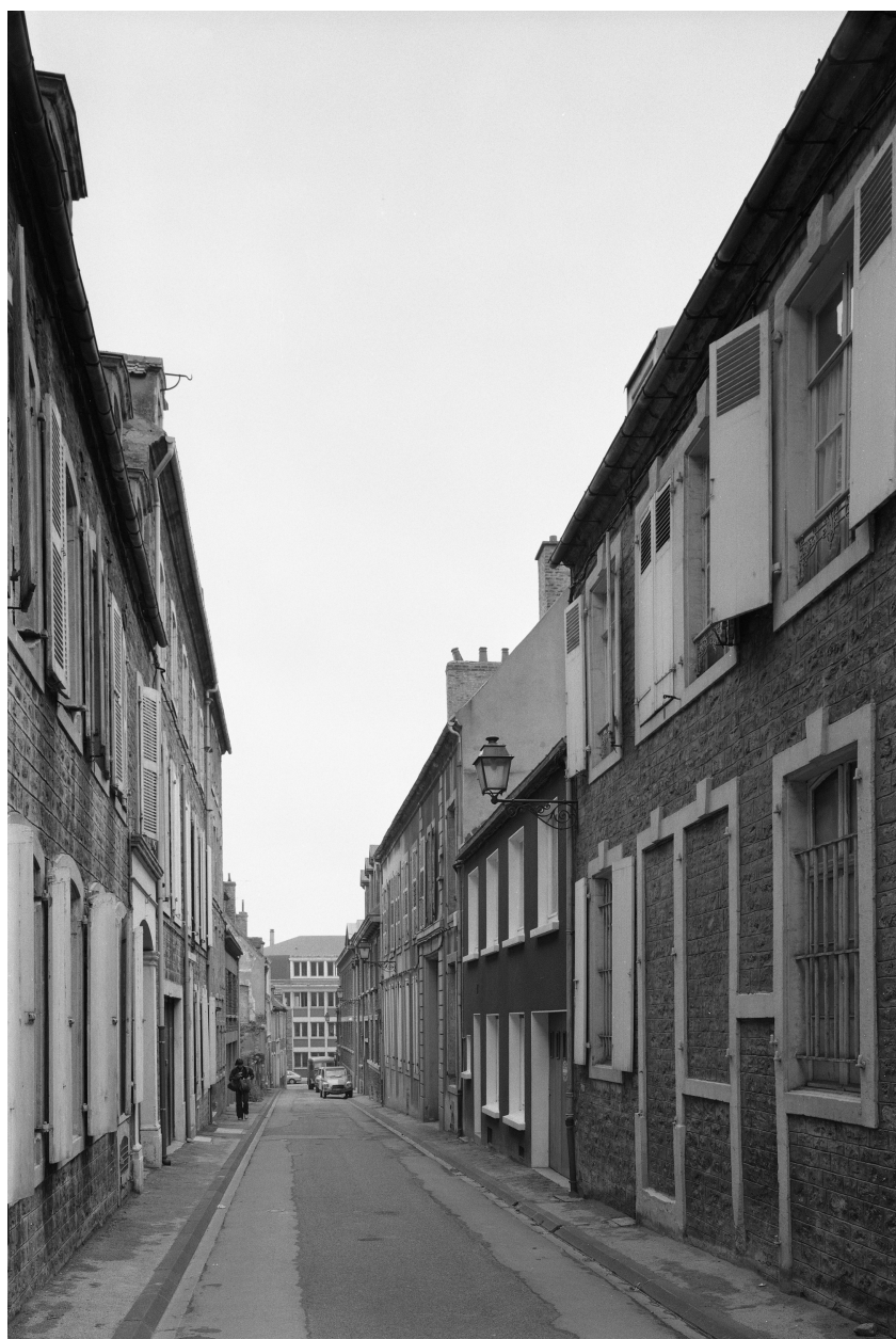
Façade rue Saint-Martin.
