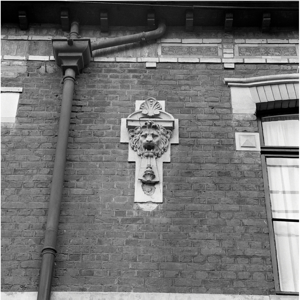
Un des décors moulés encadrant la baie du premier étage de la quatrième travée sud.
