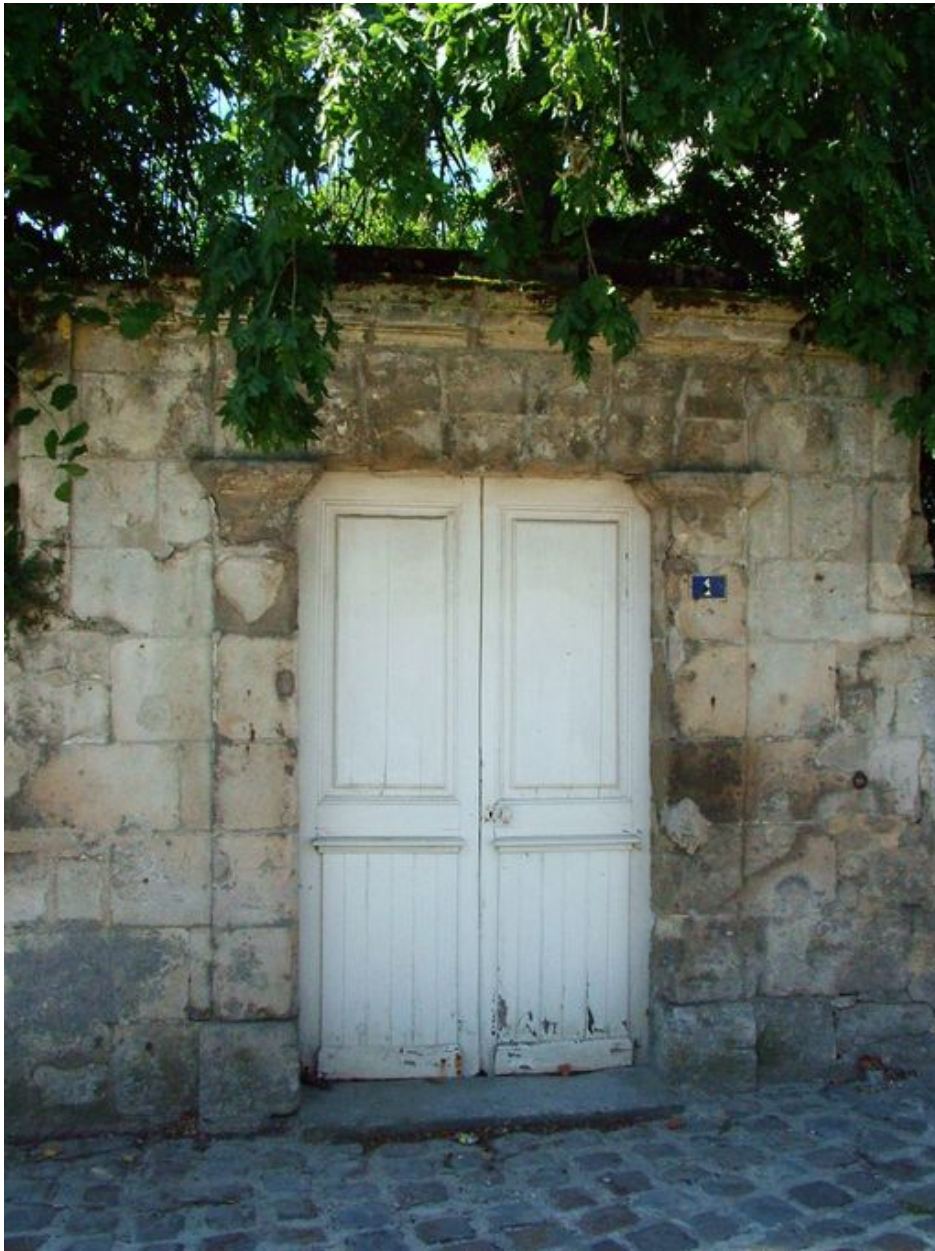
Vue de la porte piétonne latérale
