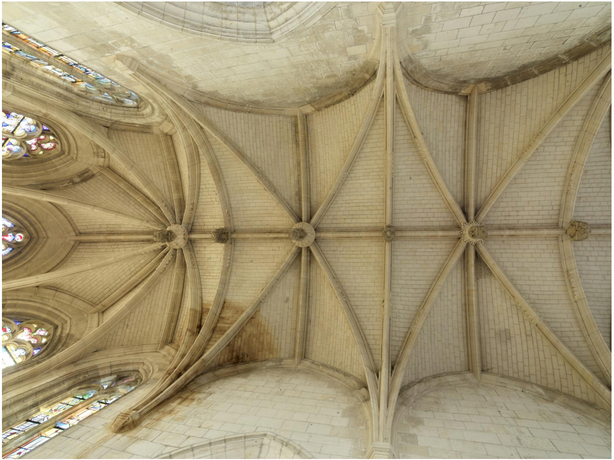
Voûte du chœur, vue d'ensemble.
