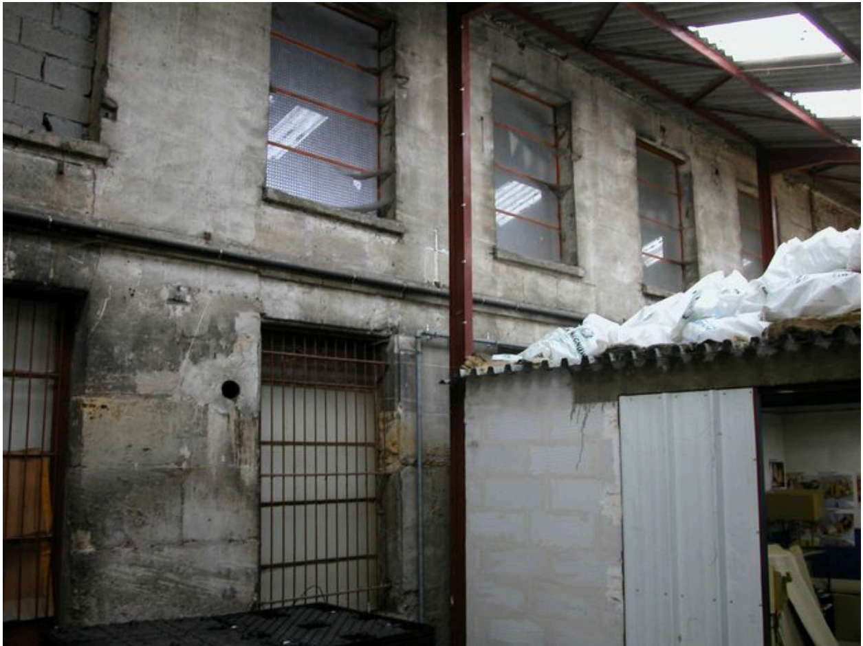
Elévation partielle de la filature Elie.
