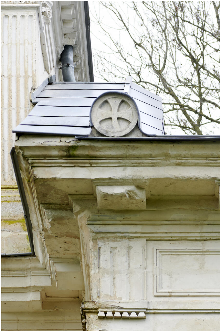
Élévation nord-ouest. Vue de détail de l'entablement, de la corniche et d'un antéfixe.
