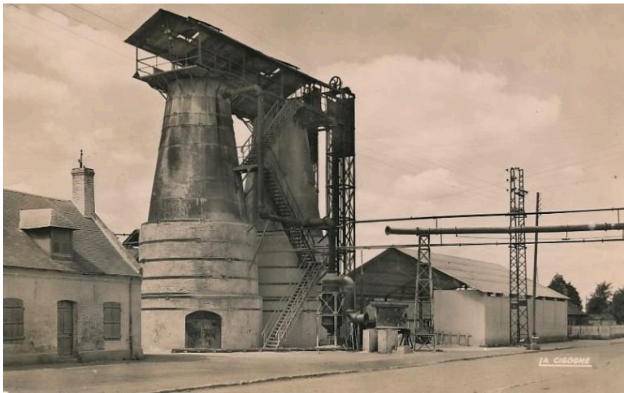
Les fours à chaux de la nouvelle sucrerie de Ham, carte postale, 1921 (coll. part).
