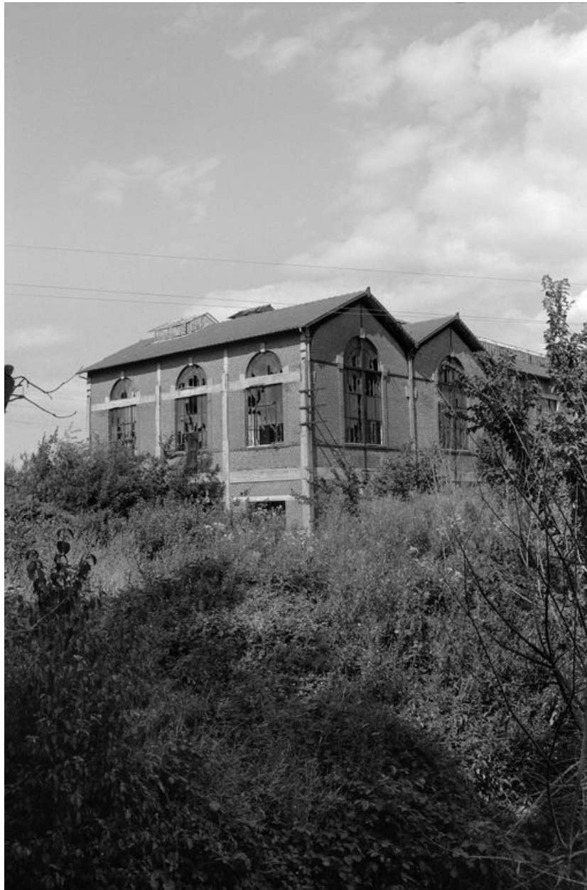
Centrale thermique, en 1988 : flanc ouest.
