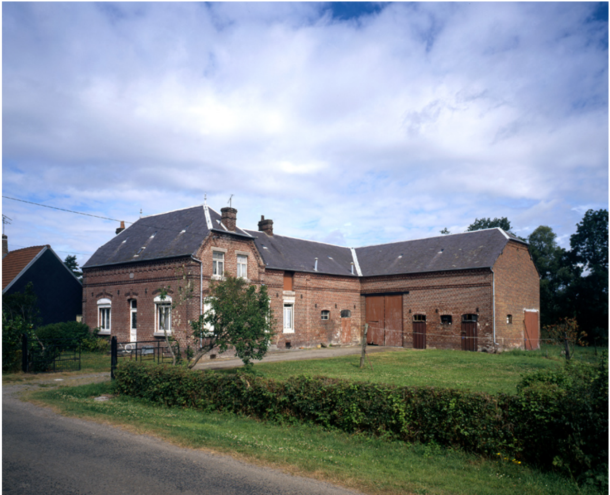
Vue générale sud de la ferme.
