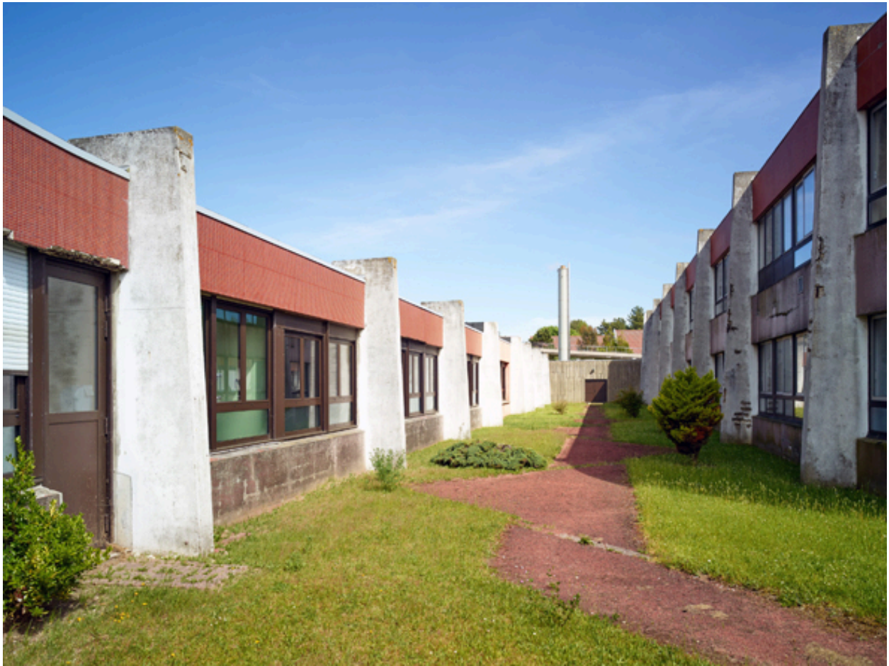
Vue générale du patio central sud est depuis la liaison entre le C.E.S. et le C.E.T.
