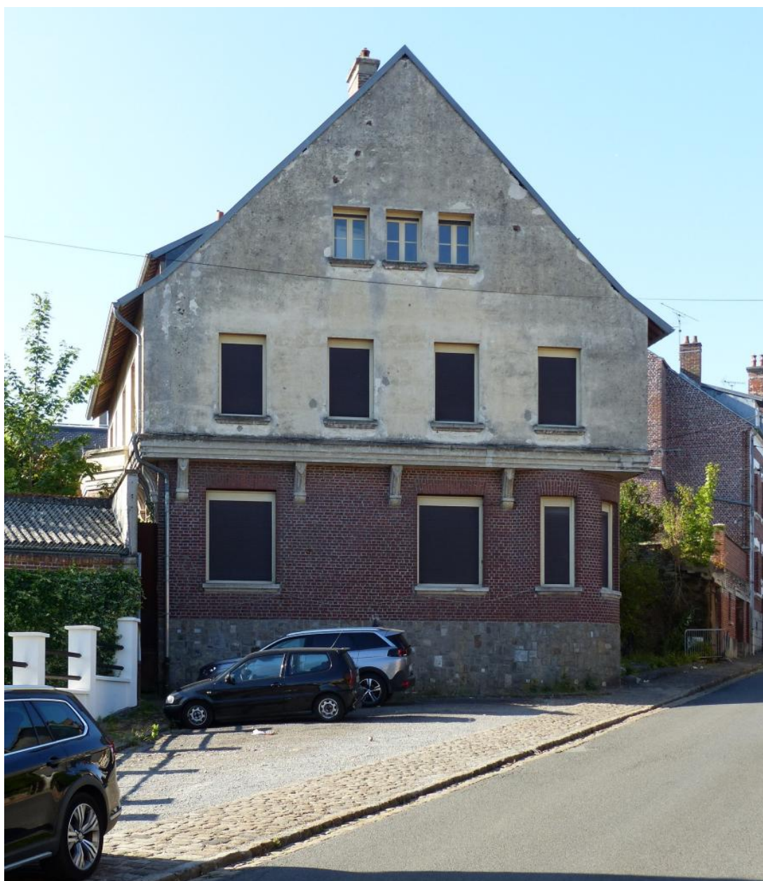
Vue de la façade nord.
