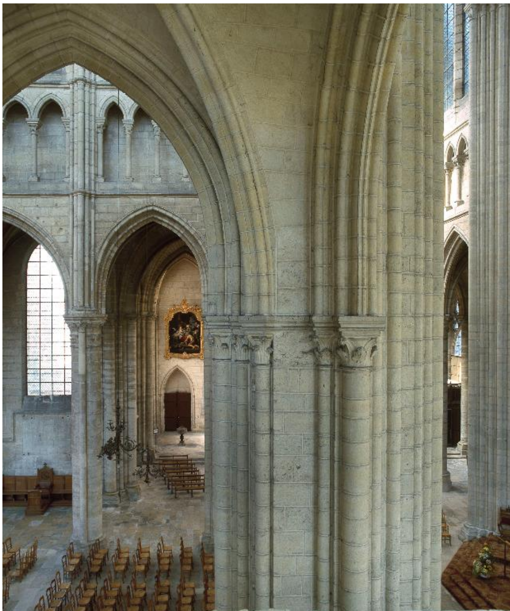
Bras sud du transept : détail du pilier sud-ouest au niveau des tribunes.
