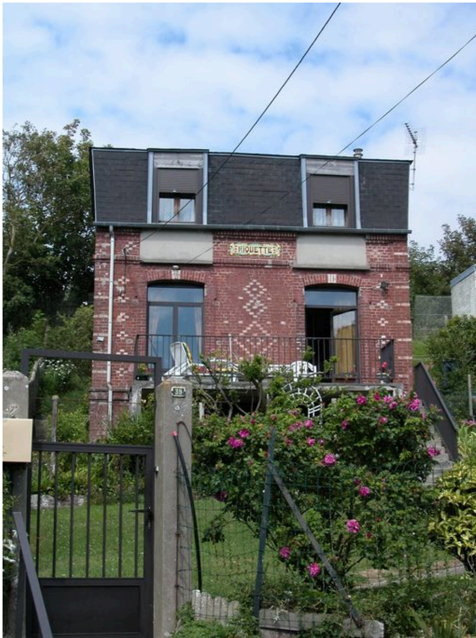
Maison dite Riquette, 39 rue Saint-Pierre (1983 AC 616).
