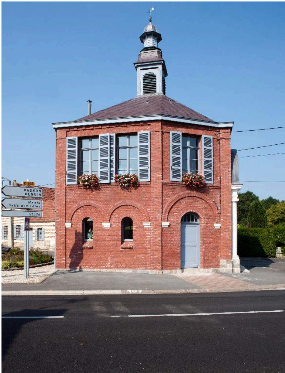
Vue de la façade de la mairie.
