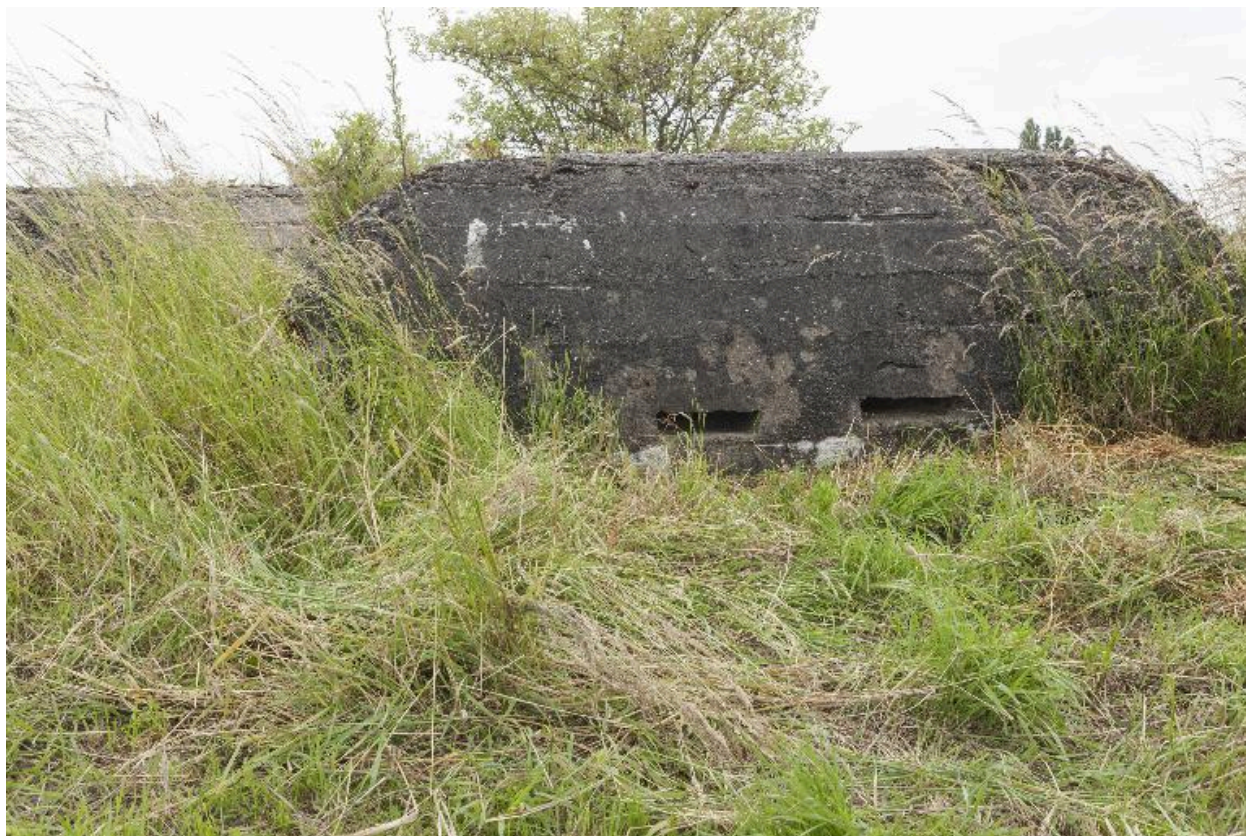
Casemate b. Elévation nord-ouest. Embrasures de surveillance
